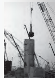
オールケーシング工法
